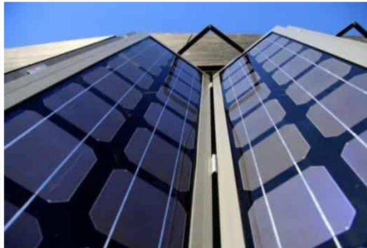
Faltladen mit PV – [baunetzwissen.de](http://baunetzwissen.de)
