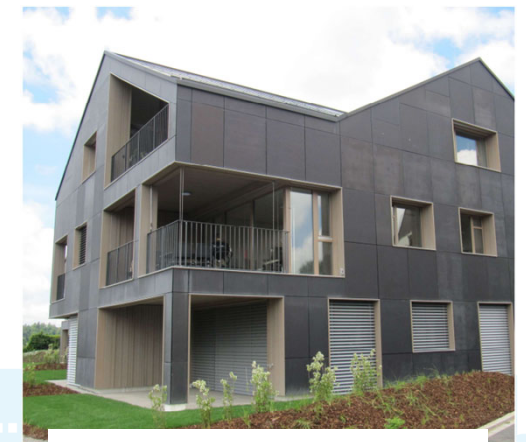
MFH Brütten, CH, BE Netz
