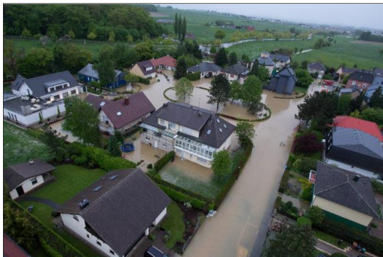
Hochwasser Cité Simminger, Mai 2013
