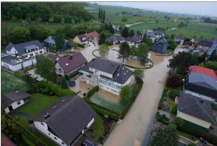
Hochwasser Cité Simminger, Mai 2013
